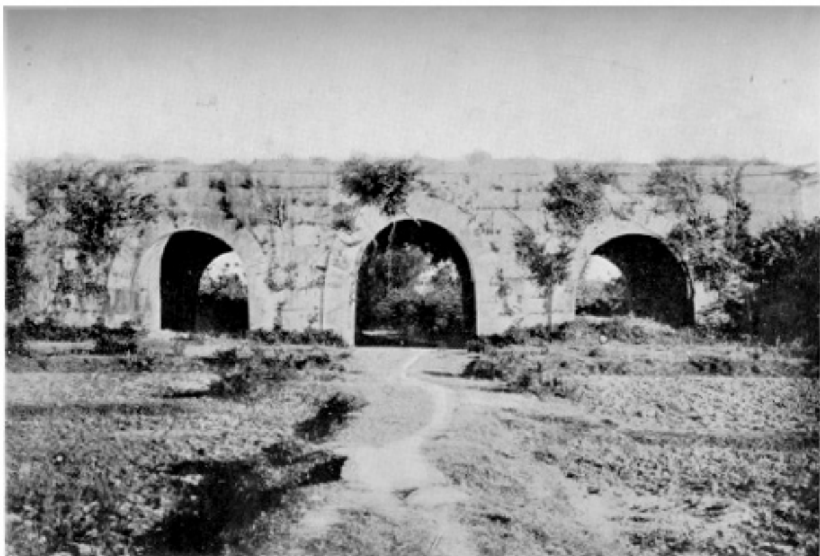
Planche XXXIII. — La porte Est -Sud -Est de la citadelle des Hố. On peut évaluer le poids de la plupart des blocs de pierre à plus de quinze tonnes.
